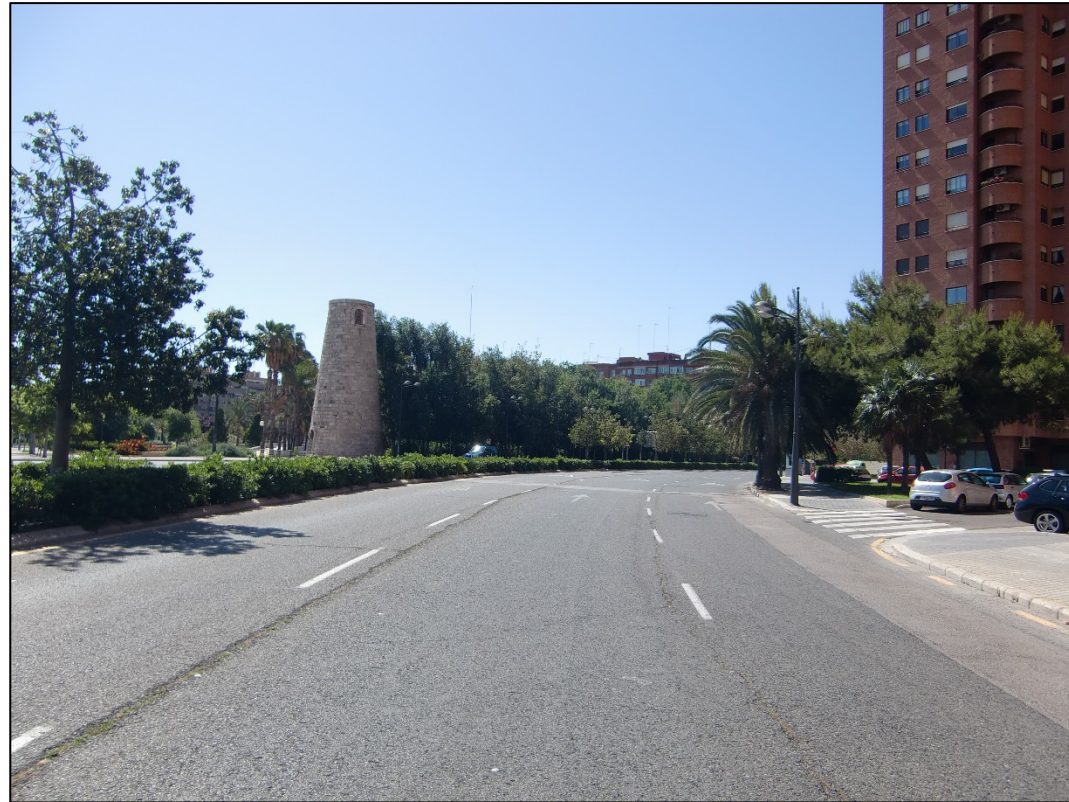
Figura 10. Zona de inicio del Colector Secundario.
